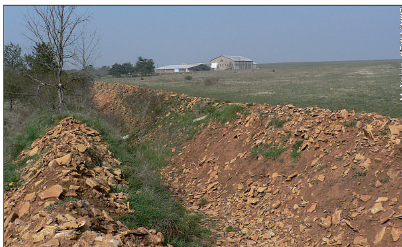
Figure 4 : fossé entourant les pistes de l'aérodrome.
