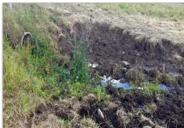
Figure n°4 - Partie du drain Sud surcreusé par le bétail, au niveau de l'exutoire du passage routier. Parallèle à la pente, il collecte une source et potentiellement les effluents de la ferme-auberge.
