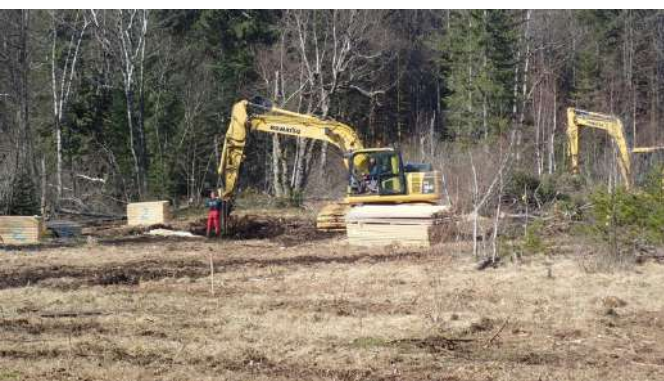
Figure 11. Travaux de restauration d'une tourbière dans le cadre du programme Life tourbières du Jura © J. Langlade / CENFC
