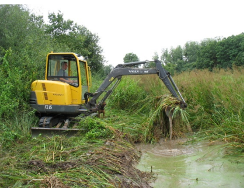
Figure 9. Travaux de curage d'une mare © CENB
