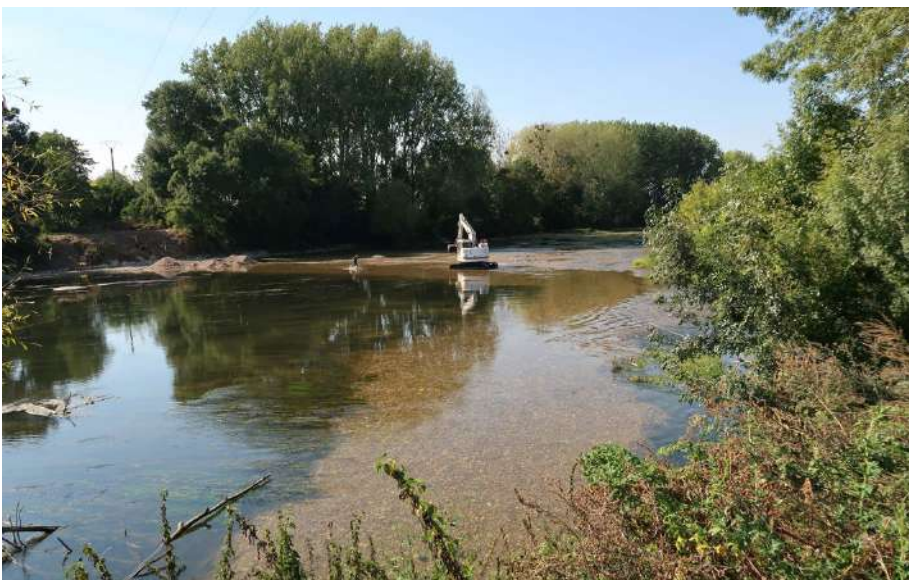
FIGURE 5 : Travaux de restauration (photo : L. Philippe).
