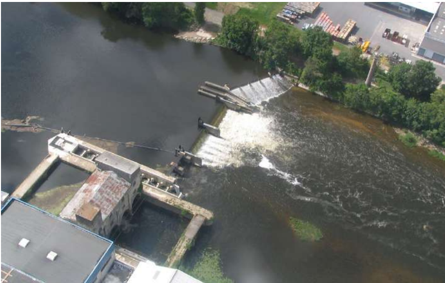
FIGURE 3 : Barrage de Descartes sur la Creuse (photo : LOGRAMI).
