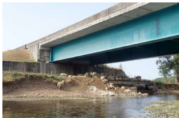
FIGURE 26 – Reposoir ombragé sur la berge.
