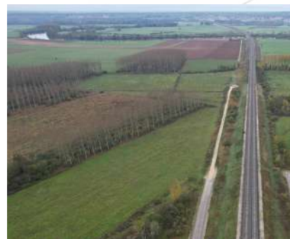
Site en novembre 2022 après les travaux de restauration
