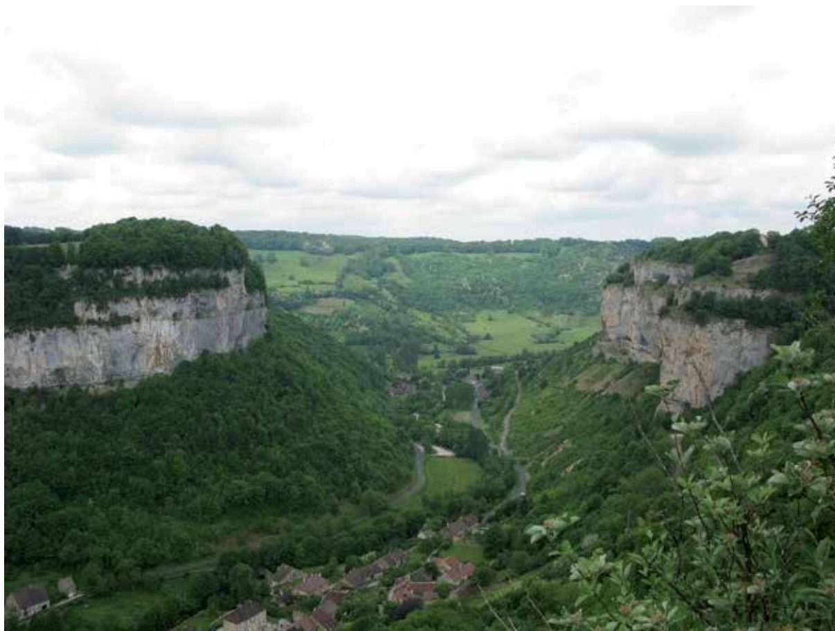
Cliché n° 1 : rupture du plateau au niveau de la reculée de Baume-les-Messieurs (39) ; les sommets des parois forment la limite de la région étudiée.
